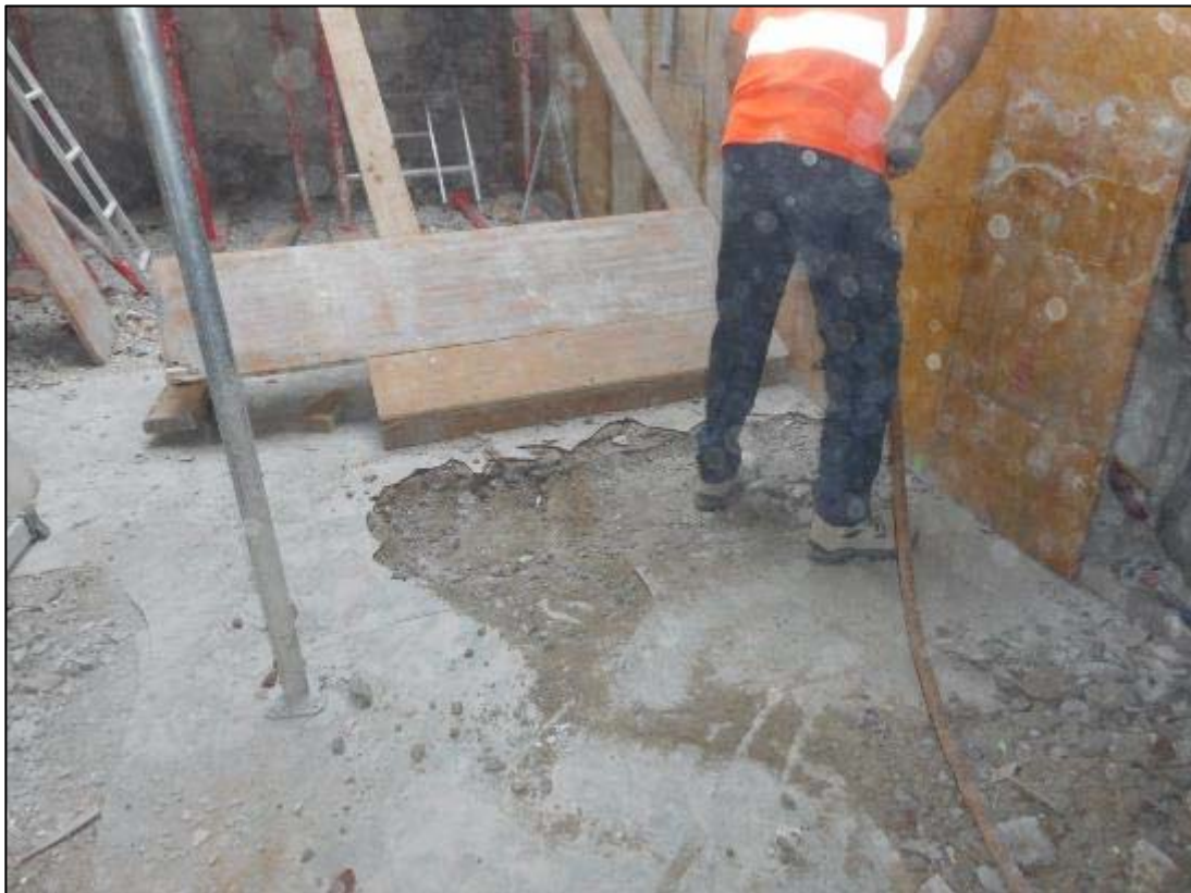
11. Inici de les tasques d'obertura de la cala de sondeig.
