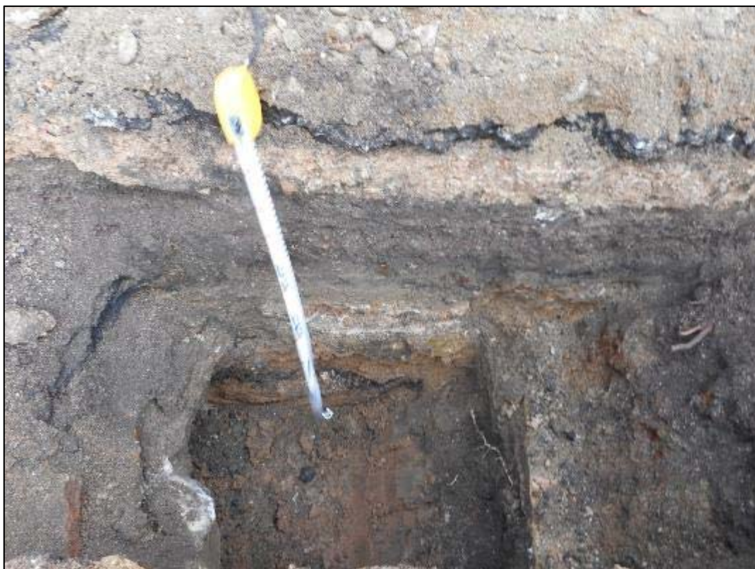
53. Finalització de la segona cala de sondeig de terres.
