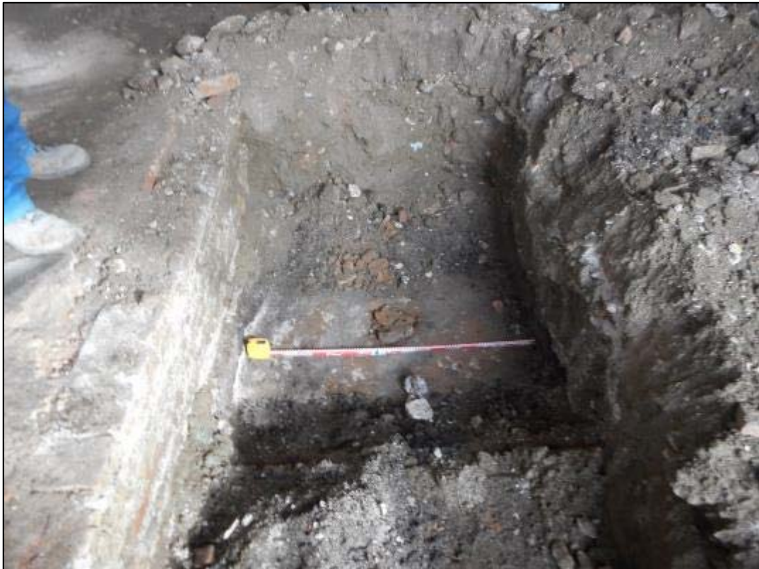
47. Cala de sondeig per a la localització de terres netes.
