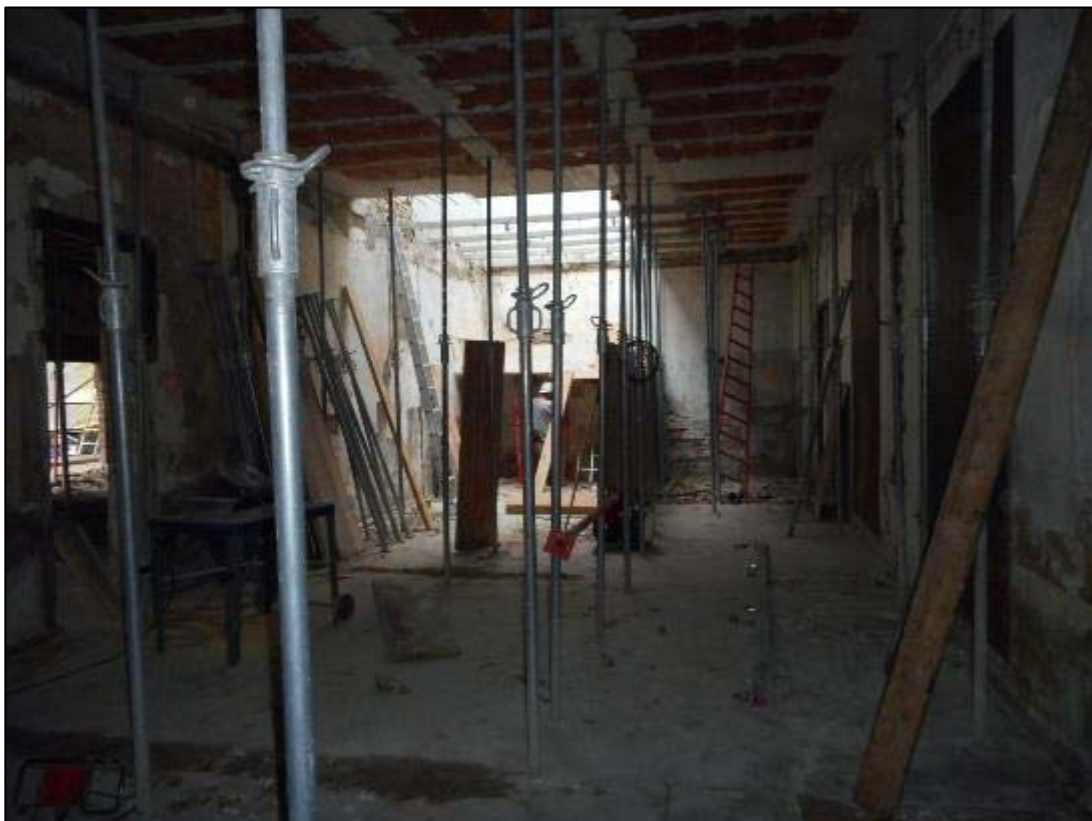
9. Sala 2 de la nau on es realitza la cala de sondeig.
