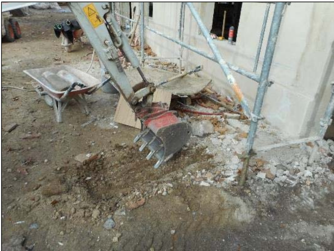
50. Cala exterior per a la localització de terres netes.
