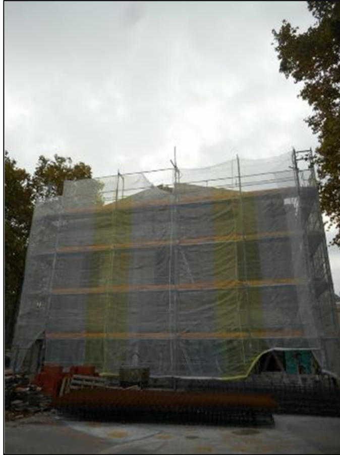
7. Façana nord de la nau on es realitza la cala de sondeig i rebaixos posteriors.
