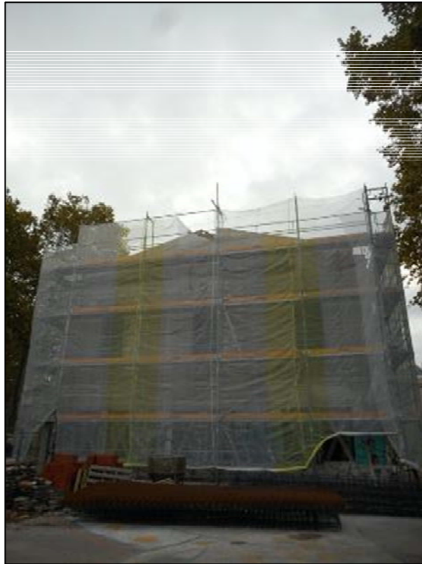
17. Vista de la façana nord de la nau annexa de Can Ricart on es duen a terme els treballs.
