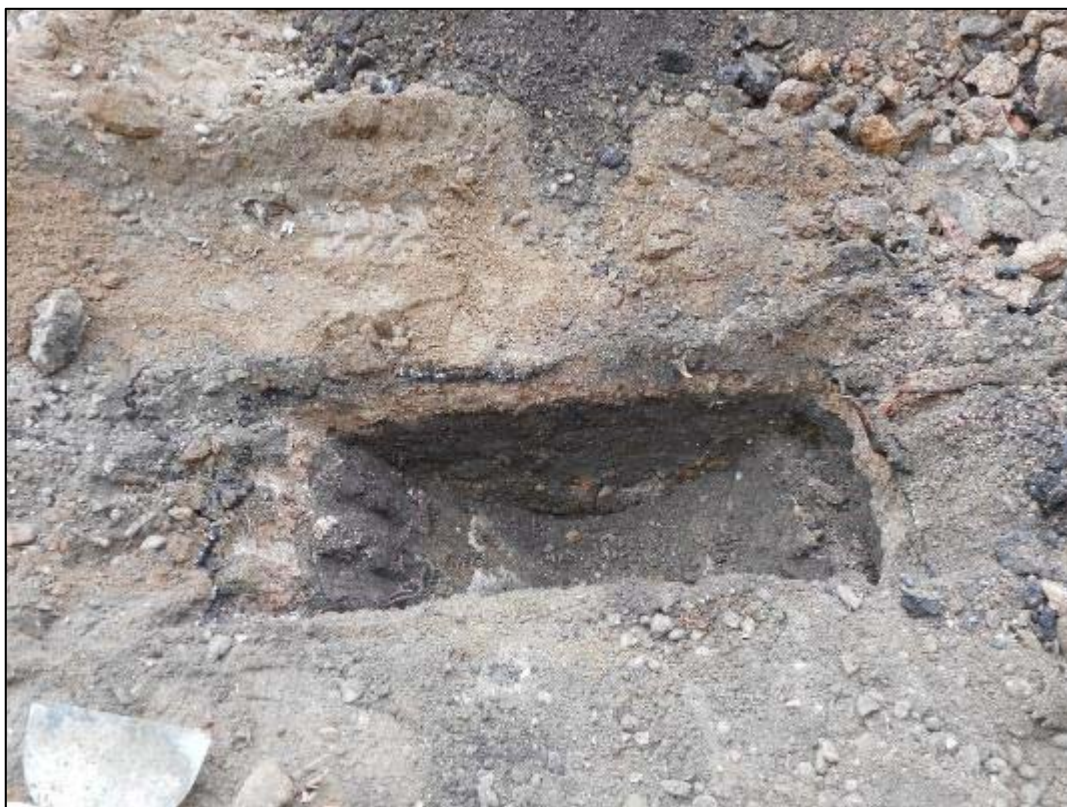
51. Finalització de la cala exterior.
